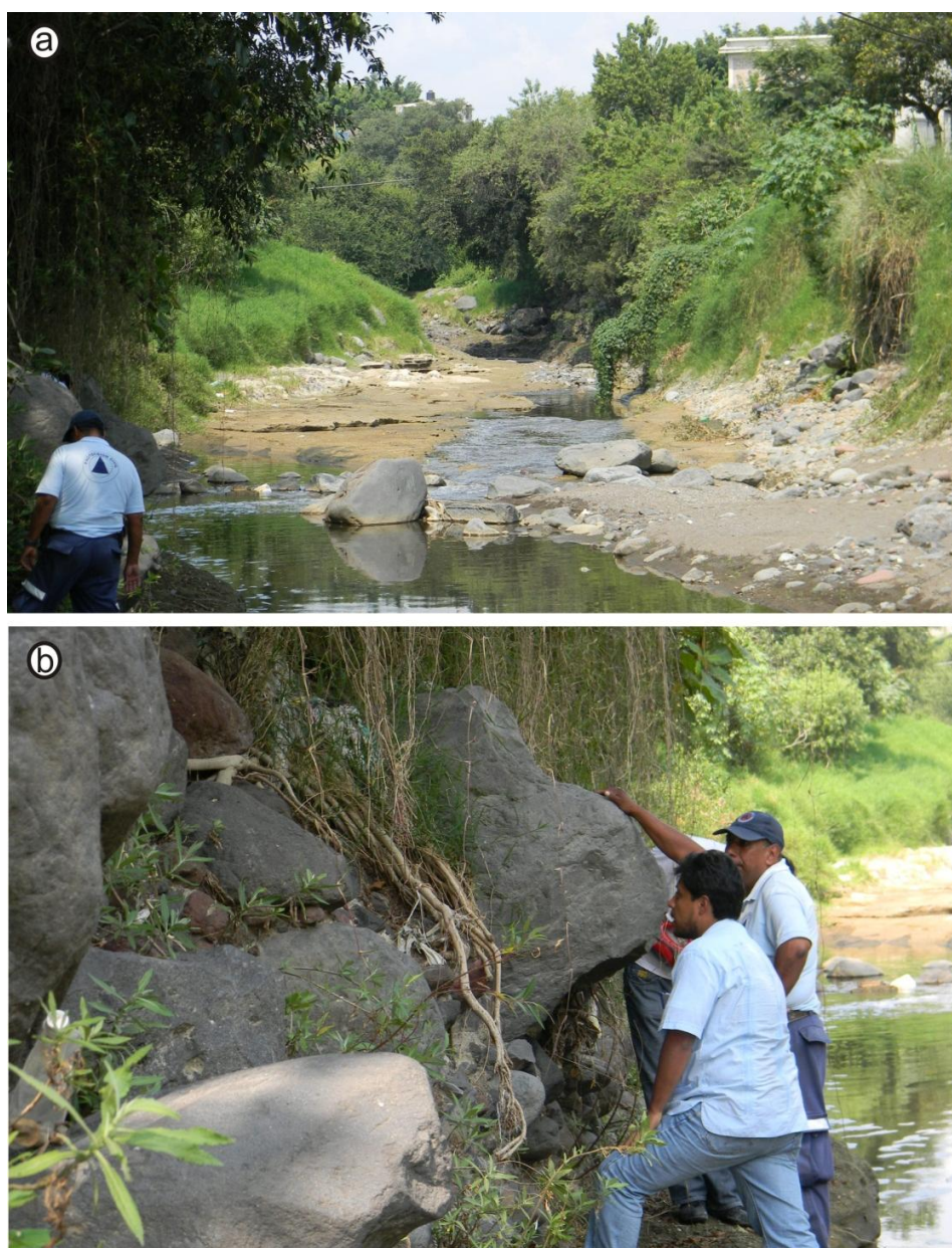
Fig. 3. Perfil transversal del río Cuautla, nótese las construcciones en el primer escalón que forma la terraza fluvial de tipo lahárica (a). En la foto inferior se muestra un acercamiento de los bloques (mayores a 1.5 m) que han quedado inmersos movilizados por lahares.
