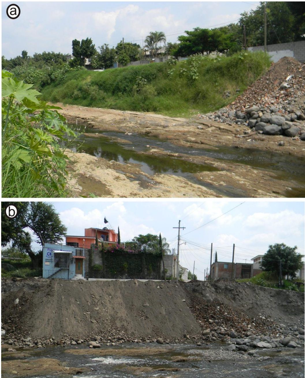
Fig. 13. A) Cauce sin acumulación lateral al talweg. B) Relleno lateral de la ribera del río Cuautla.
