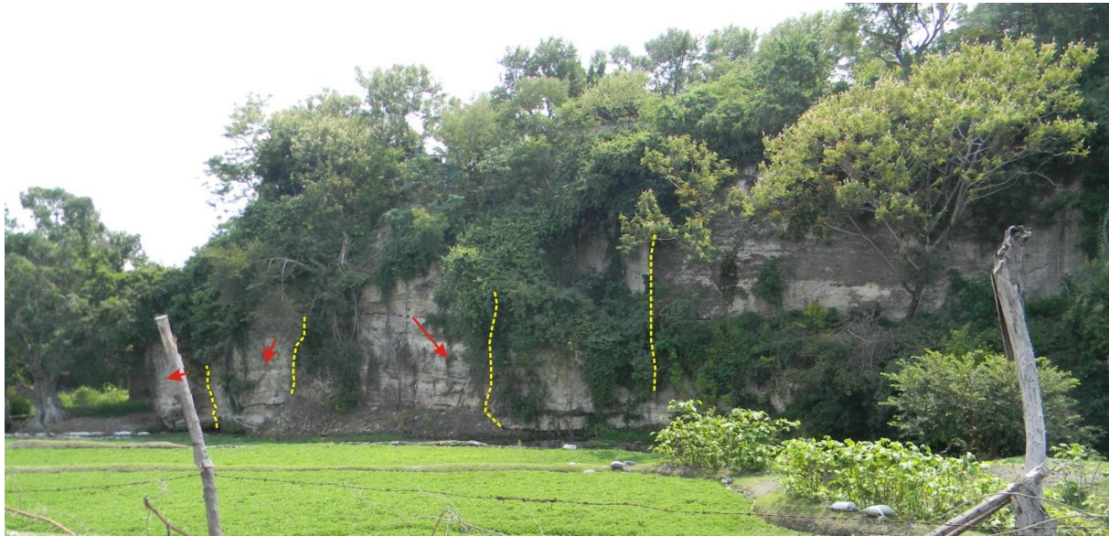
Fig. 10. Ribera del río Cuautla. La fotografía muestra el reacomodo en bloques (flechas rojas) de las rocas que componen a la ribera producto del desarrollo de pequeños túneles en su interior.
