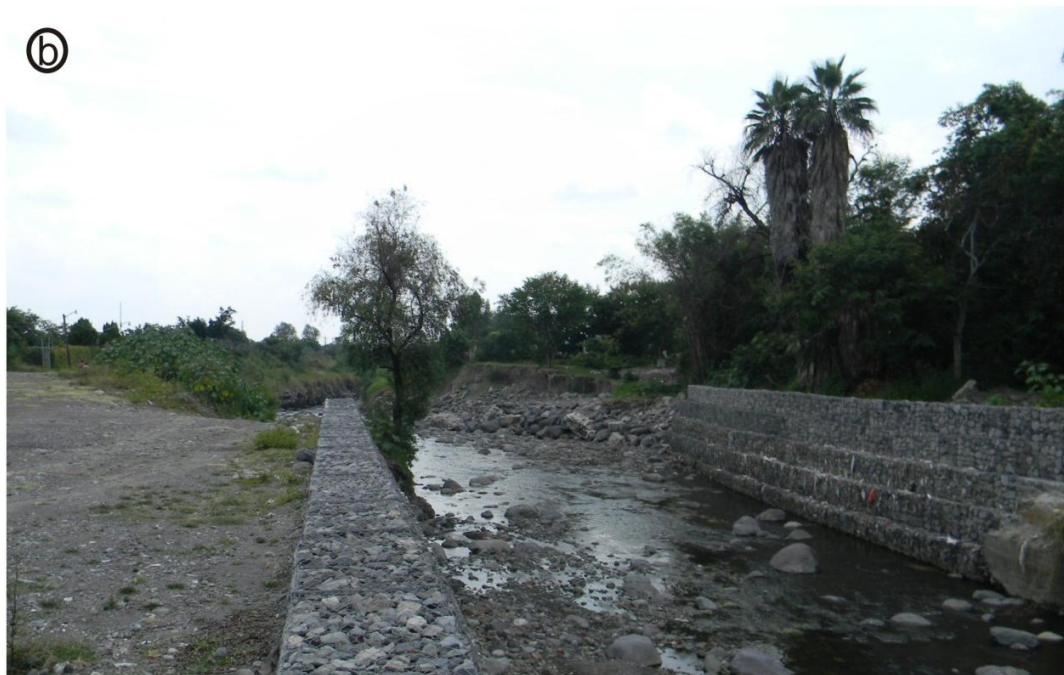
Fig. 14a. Fotografía del cauce aparente en donde se redujo su amplitud y se canalizo en una zona curva, esto ha impactado constantemente los gaviones al grado de removerlos. 14b. Canalización recta del cauce, esto acelera la erosión en la terraza al fondo, como la amplitud se incrementa el río suelta la carga de mayor tamaño, nótese los grandes bloques depositados en el margen inferior de la terraza.
