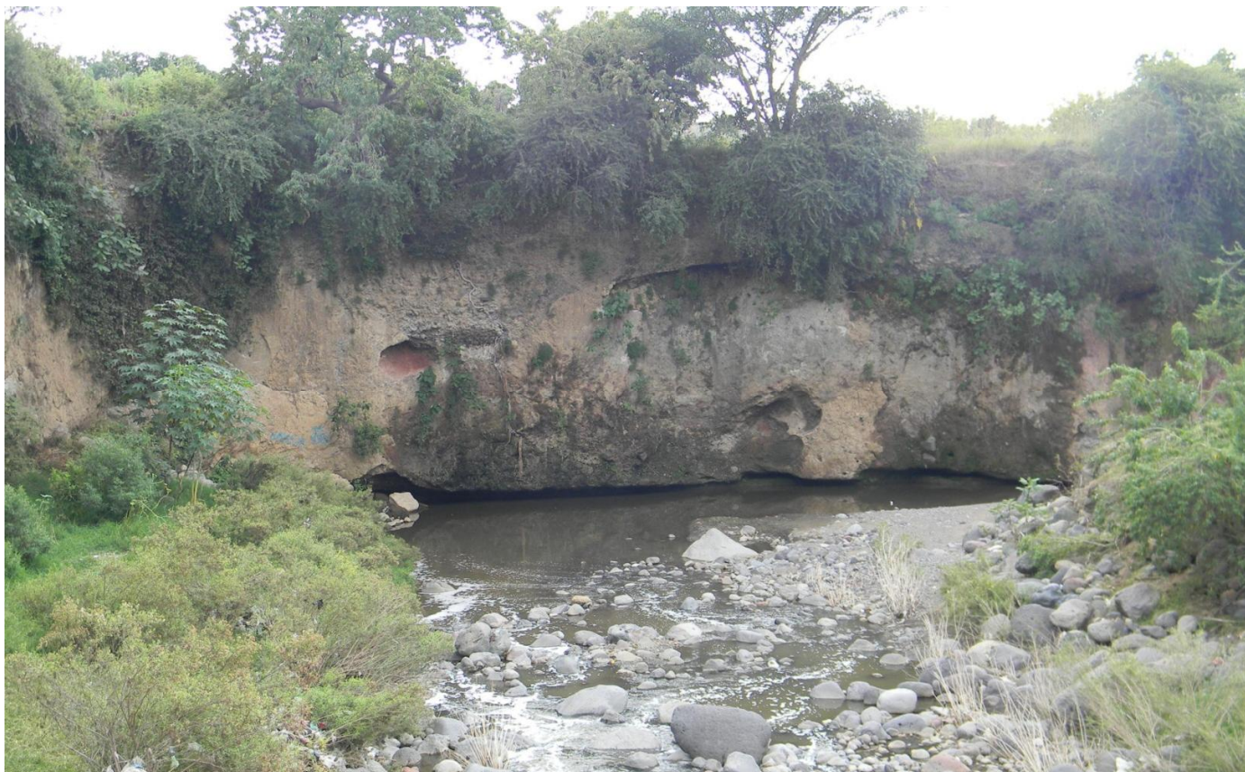
Fig. 15. Fenómenos de zapa en la base de la ribera del río Cuautla.
