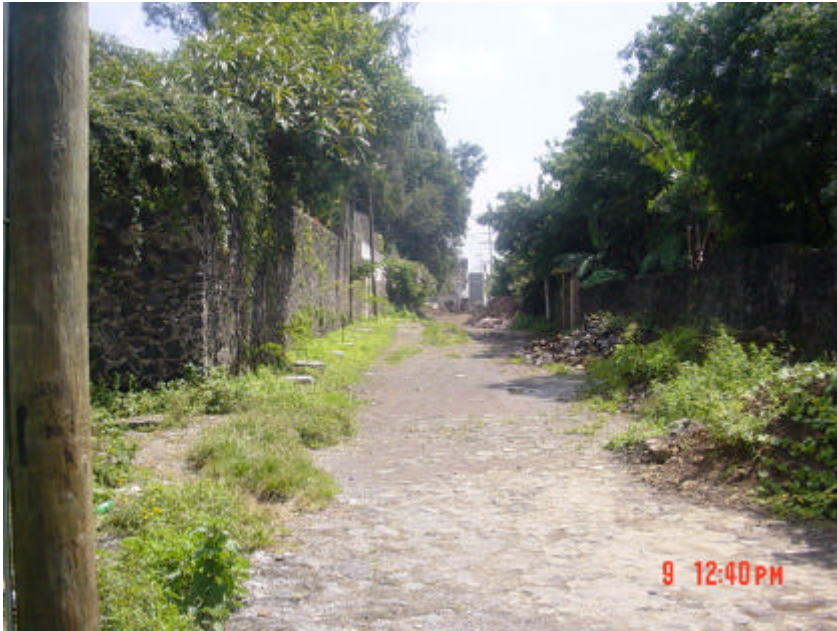
Calle Hermenegildo Galeana vista hacia el puente en construcción que unirá a las dos áreas del polígono, actualmente divididas por la autopista (foto 5)
