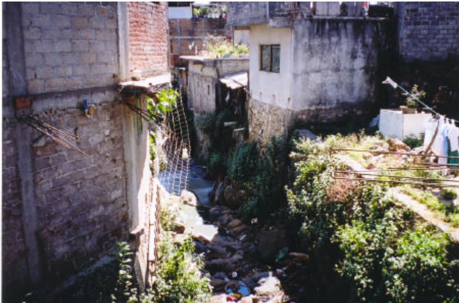
Cauce de la barranca localizada al Oriente de la colonia nueva Jerusalén, vista desde la calle Jericó. Construcciones al límite del cauce de la barranca. Descargas de aguas residuales sin tratamiento y desechos sólidos sobre el cauce de la barranca. (foto 12)
