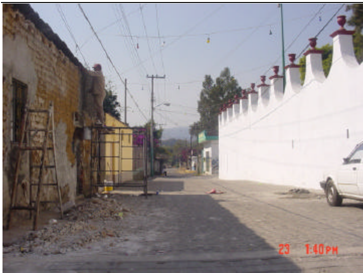
Vista de la calle José María Morelos hacia el Poniente en donde se aprecian la barda de la iglesia y construcciones típicas de adobe. (foto 11)
