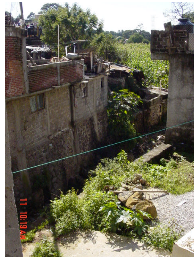
Construcciones al límite del cauce de la barranca y sobre la zona federal, colonia Nueva Jerusalén (foto 2)
