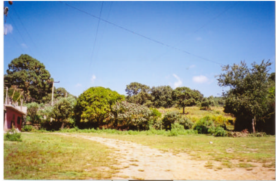
Derecho de vía de líneas de alta tensión, colonia Lomas de Chamilpa (foto 8)
