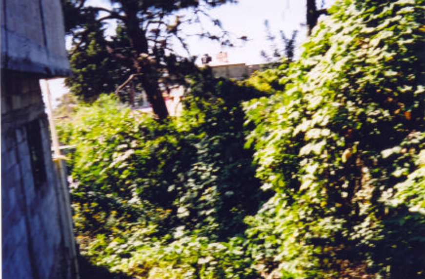
Construcción en el límite del cauce de la barranca, Colonia Lomas de Chamilpa (foto 5)
