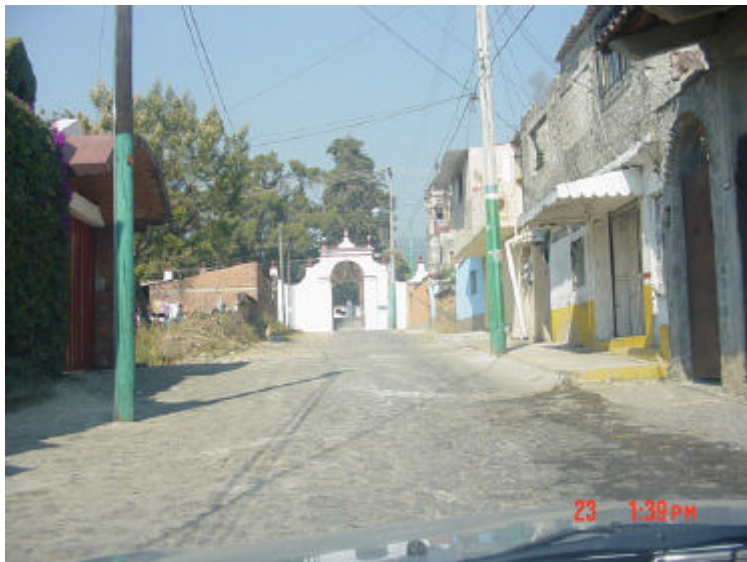
Vista de la calle Ignacio Allende de Sur a Norte, en donde se aprecia la tipología de las construcciones y la vialidad empedrada, la ausencia de banquetas y la iglesia al fondo, sobre la calle José María Morelos. (foto 9).
