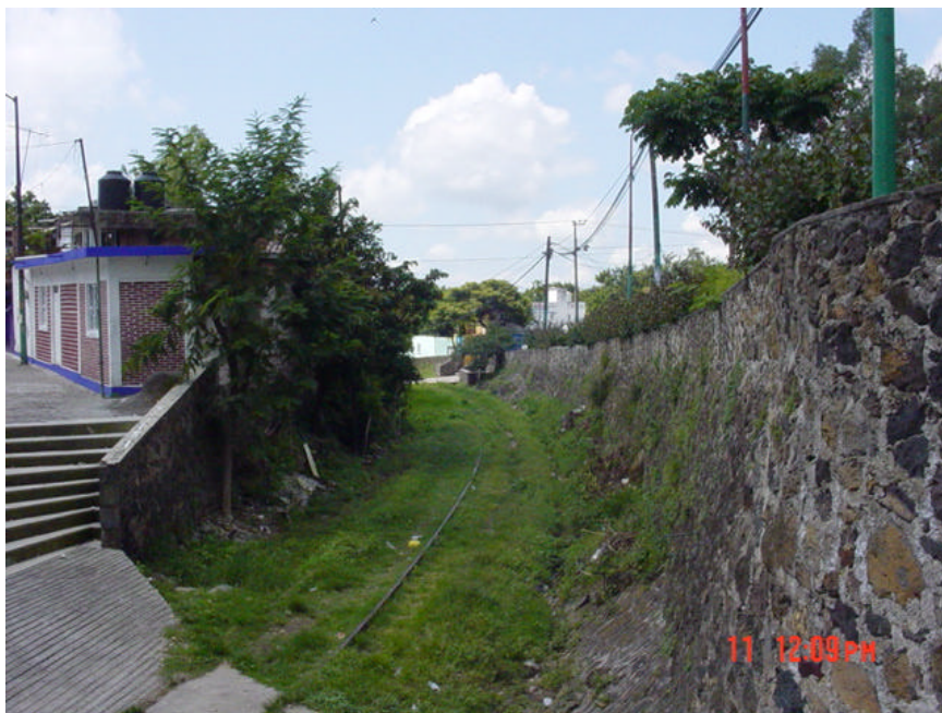
Derecho de vía del ferrocarril México-Balsas, limitado por muro de contención. A la izquierda vivienda con escarga de aguas residuales a la zona federal. (foto 2)
