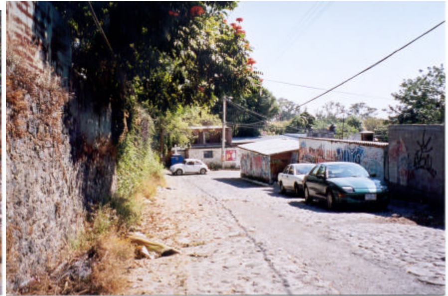
Calle Emiliano Zapata con construcciones fuera de alineamiento y sin banquetas lo que obliga a los peatones a transitar por el arroyo vehicular. (foto 7)
