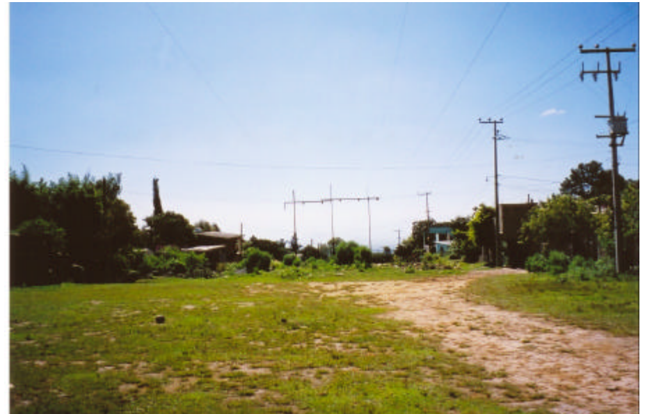
Derecho de vía de líneas de alta tensión, Colonia Lomas de Chamilpa (foto 6)
