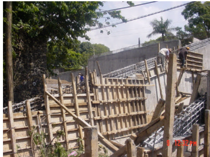
Puente Chamilpa en construcción que comunicará las dos áreas del polígono (foto 2)
