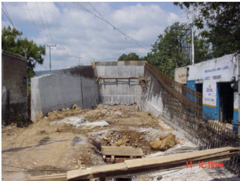
Puente en construcción sobre autopista, calle Hermenegildo Galeana (foto 13).
