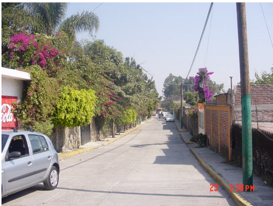
Vista de la calle Narciso Mendoza con pavimento de concreto hidráulico y sin red de drenaje, con comercio básico (foto 14).
