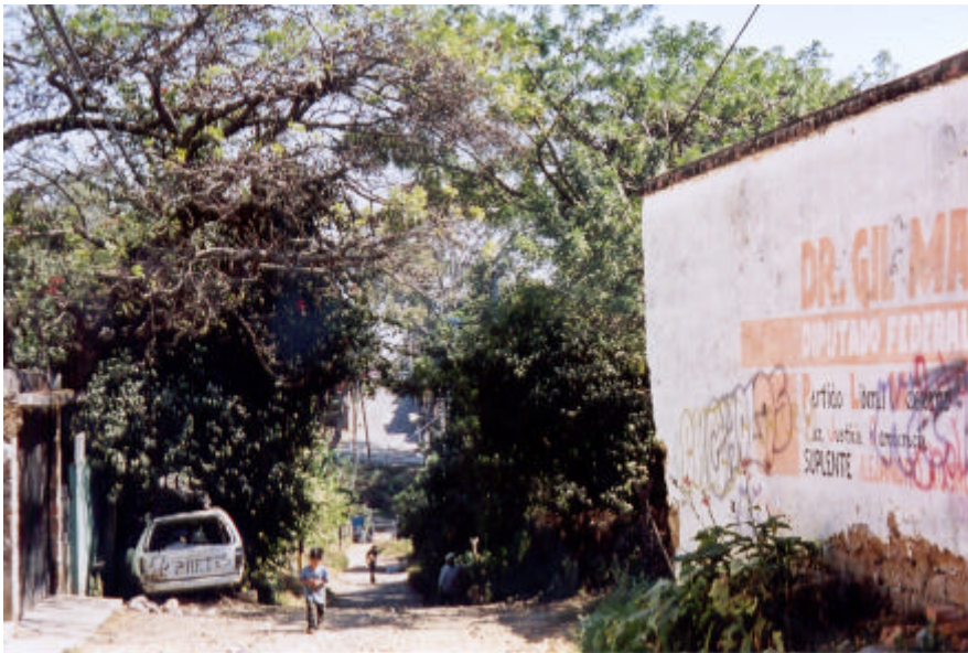
Vista de la calle Vicente Guerrero hacia el Oriente, al fondo se ubica la barranca. Esta calle se comunica mediante un paso peatonal con la carretera federal México-Cuernavaca. Carece de pavimento y tiene una sección de 5 metros aproximadamente. La vivienda en esta calle es popular. (foto 14)
