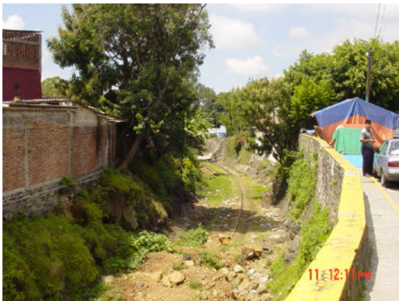
Derecho de vía del ferrocarril México-Balsas, viviendas construidas al límite del derecho de vía. (foto 3)
