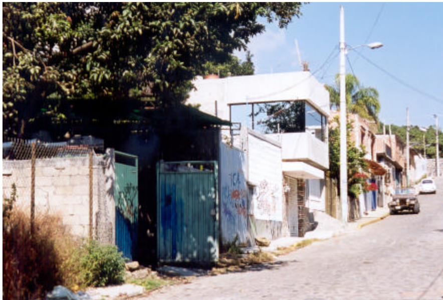
Vista de la calle Ignacio Allende hacia el Norte del polígono en donde se puede apreciar la tipología de vivienda que se encuentra mezclada, la primera vivienda es precaria, la que sigue es de tipo medio y las demás son viviendas populares de construcción progresiva. Se aprecian también los servicios de energía eléctrica y alumbrado público, así como el empedrado de la calle. (foto 5)
