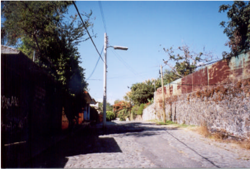
Calle Emiliano Zapata con empedrado y sin banquetas línea de agua superficial (foto 6)
