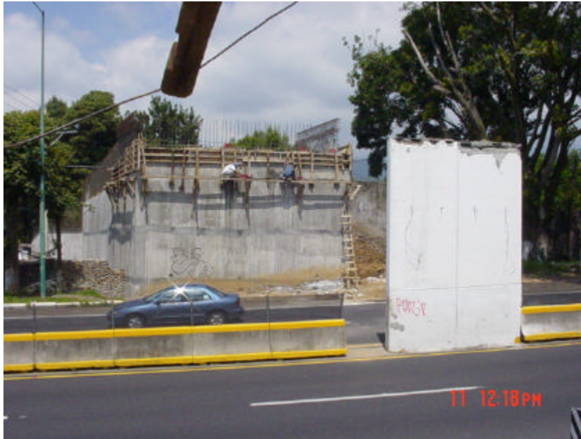
Proceso de construcción de puente sobre la autopista (foto 12)
