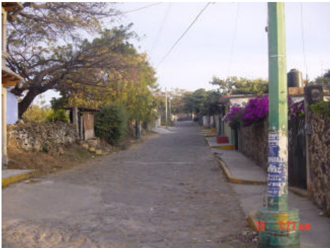
Calle Emiliano Zapata hacia el Norte donde se aprecia la tipología de las construcciones y la ausencia de banquetas en la acera poniente (foto 6)
