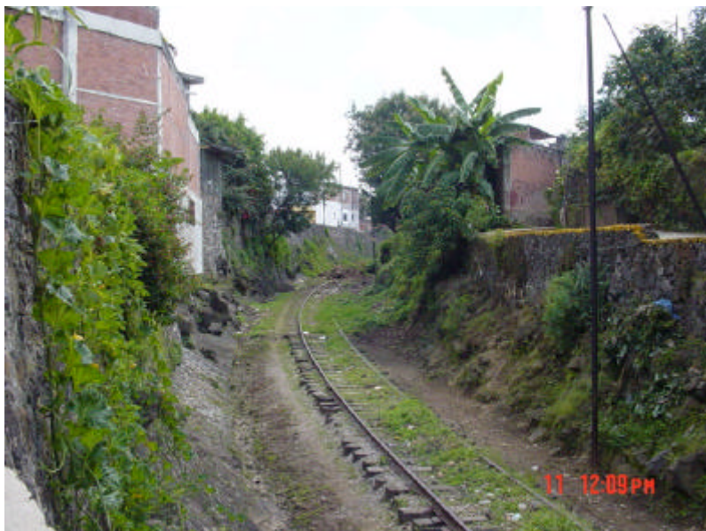
Derecho de vía del ferrocarril México-Balsas. Se aprecian construcciones habitacionales al límite de la zona federal (foto 1)
