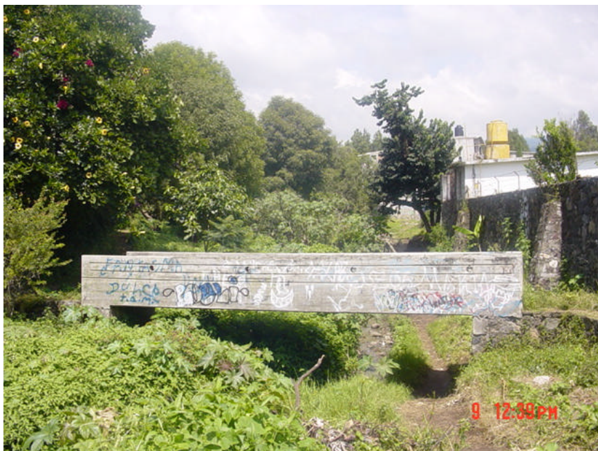
Puente peatonal sobre la barranca localizada al Poniente del polígono (foto 3)
