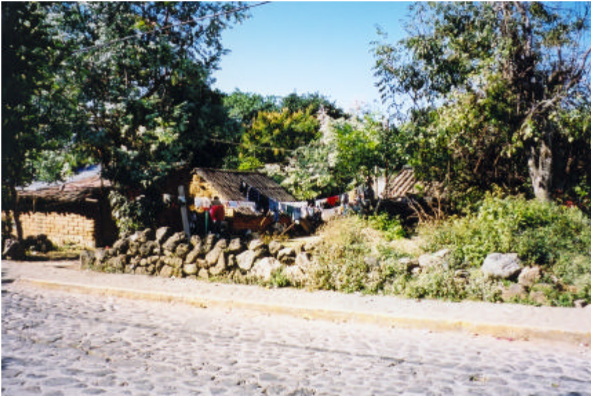
Casas precarias, calle Galeana (foto 13).
