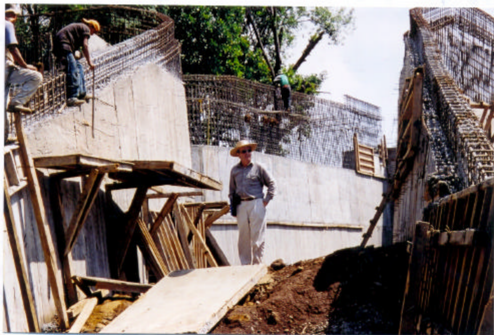
Puente en construcción sobre la autopista que comunicará las dos áreas del polígono (foto 10)
