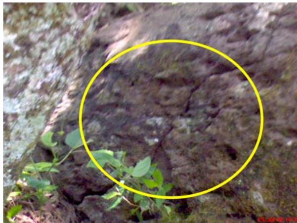
*Foto 1A, mostrando huellas de barrenos para volar con explosivos la roca de la foto Z, lo cual no es conveniente.*
