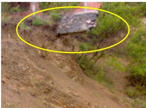
*Foto mostrando una zona de peligro natural de grado alto por deslizamiento de miles de toneladas, se ve la base del cimiento de una barda de casa en la calle Rancho Grande 22 junto a la Iglesia en la colonia J. López Portillo,*
