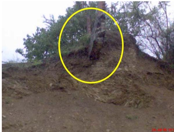
*Vista del deslizamiento en este tipo de litología (arcillas), nótese la base del cimientado visto de frente que se encuentra totalmente desprendido del macizo rocoso en el que fue enclavado inicialmente y debido a los derrumbes a quedado completamente expuesto.*
