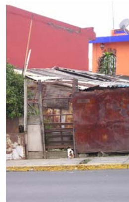
Asentamiento Irregular (Col. Lienzo del Charro, Cuernavaca) Consolidado VS. Precario. Foto mivm, 2005.
