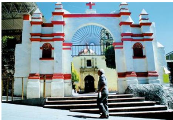
Figura 256. Parroquia de San Francisco Zacualpan en el municipio de Emiliano Zapata
