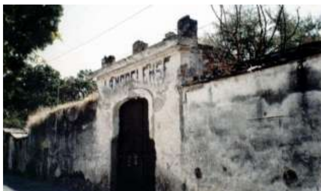
Ruinas de la fabrica "La Morelense"
